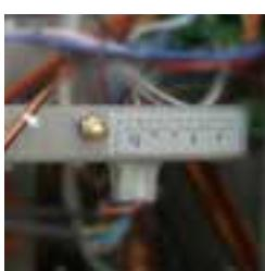
Connessione pratica e veloce per il collegamento delle sonde esterne di rilevazione dei parametri impianto, del termostato esterno e ad eventuali altri generatori di calore.
