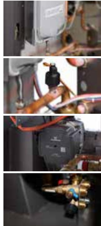
Il **circolatore ad alta efficienza a controllo elettronico** di serie, assicura massima flessibilità di installazione. Può essere tarato in base alle esigenze dell'impianto termoidraulico scegliendo direttamente dal display tra **4 impostazioni** che determinano la portata dell'acqua. Regola la quantità d'acqua immessa nell'impianto in base alla temperatura dell'acqua in caldaia.
