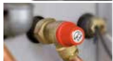
**Il termostato di sicurezza** aumenta il livello di sicurezza generale (sonda termostatica a riamo manuale), **interviene se la temperatura supera la soglia di sicurezza**.
