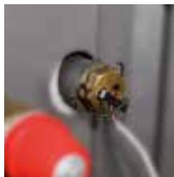
Verifica la temperatura dell'acqua di ritorno dall'impianto, prevenendo eventuali surriscaldamenti causati da anomalie o sottodimensionamenti dell'impianto: se la differenza di temperatura dell'acqua tra la mandata e il ritorno è troppo bassa la scheda elettronica attiva il blocco della macchina facendola ripartire al rientro dei parametri nei limiti impostati e senza necessità di intervenire manualmente per il riavvio della macchina stessa.
