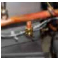
La sonda S1 per gestione dell'accumulo e la sonda S2 per gestione dell' accumulo per l'acqua calda ad uso sanitario sono fornite di serie. Fondamentali per implementare il prodotto con l'impianto e renderne ottimale il funzionamento in base alle necessità evitando inutili sprechi di combustibile.
