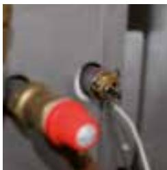
Verifica la temperatura dell'acqua di ritorno dall'impianto. Previene eventuali surriscaldamenti causati da anomalie o sottodimensionamenti dell'impianto: se la differenza di temperatura dell'acqua tra la mandata e il ritorno è troppo bassa la scheda elettronica attiva il blocco della macchina facendola ripartire al rientro dei parametri nei limiti impostati e senza necessità di intervenire manualmente per il riavvio della macchina stessa.
