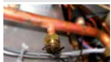
**ES** La función de **seguridad antihielo** enciende automáticamente el circulador del monobloque si la temperatura del agua de la caldera disminuye por debajo de los 5 grados, para que el congelamiento no comprometa el monobloque y la planta térmica. La **válvula de seguridad** a 3 bar para el control de la presión, permite utilizar el monobloque en completa seguridad.
