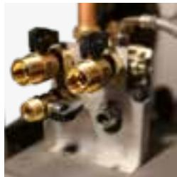
Il kit optional permette di separare il prodotto dall'impianto, senza dover svuotare e successivamente riempire l'impianto termico nel caso di manutenzione. Agevola, semplifica e soprattutto riduce i costi di intervento.
