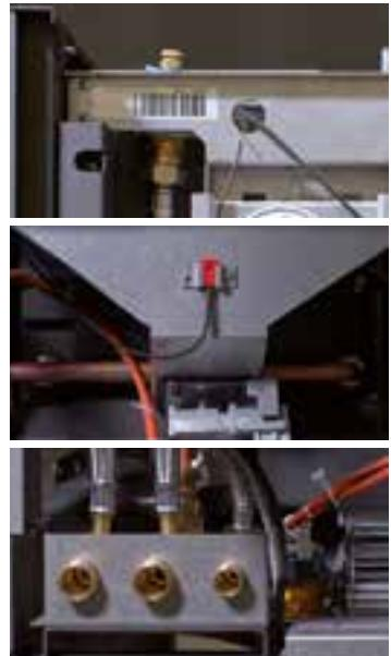
La **sonda di mandata impianto** rileva la temperatura dell'acqua in mandata della caldaia **gestendo in base a questo ben 16 diversi livelli di potenza**. Gli intervalli minimi tra le potenze dei diversi livelli assicurano una piacevole visione della fiamma non essendo soggetta ad improvvisi sbalzi.
